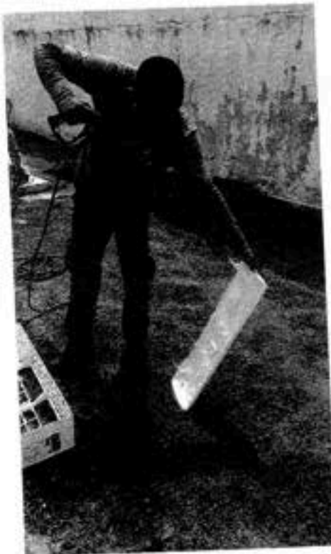
Lavagem com o jato de pressão 1
